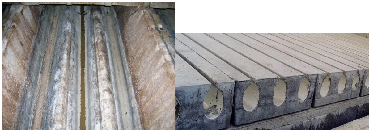
Photo 1 Caniveaux sous caillebotis (photo de gauche) et Gouttières dans le sol (photo de droite) Source : Chambre d'Agriculture de Bretagne
