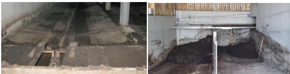
Photo 1 : vue du racleur en V sous caillebotis (à gauche) et stockage intermédiaire de la fraction solide (à droite)(crédits photos : IFIP Institut du Porc)
