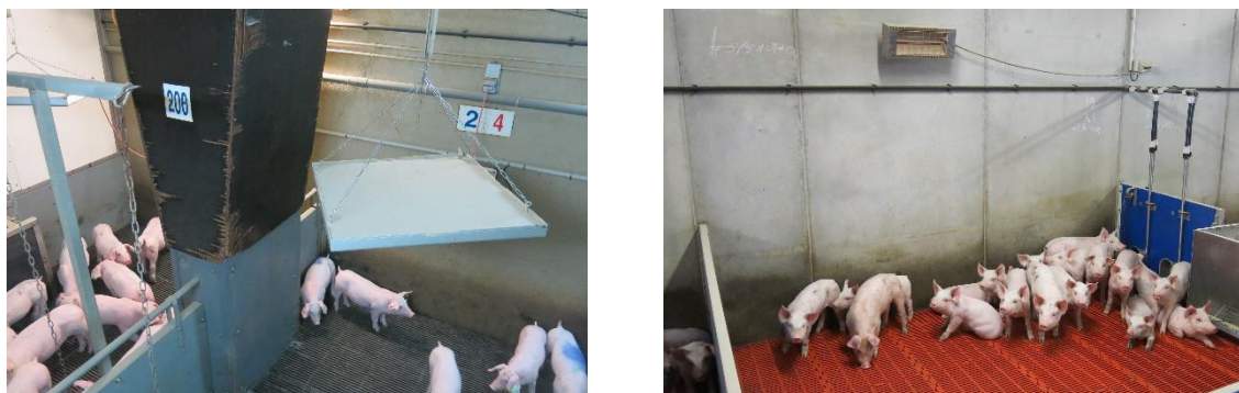
Figure 2 : Dispositifs de chauffage nouvelle génération, à gauche, un chauffage IR à ondes longues et à droite un chauffage IRC halogène (crédits photos IFIP)
