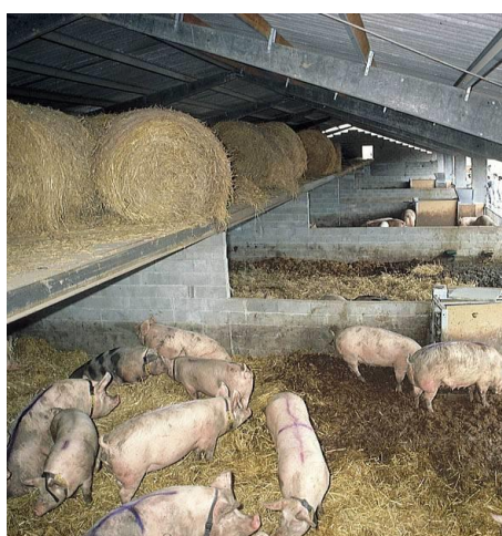
Sol en béton plein entièrement recouvert de litière
