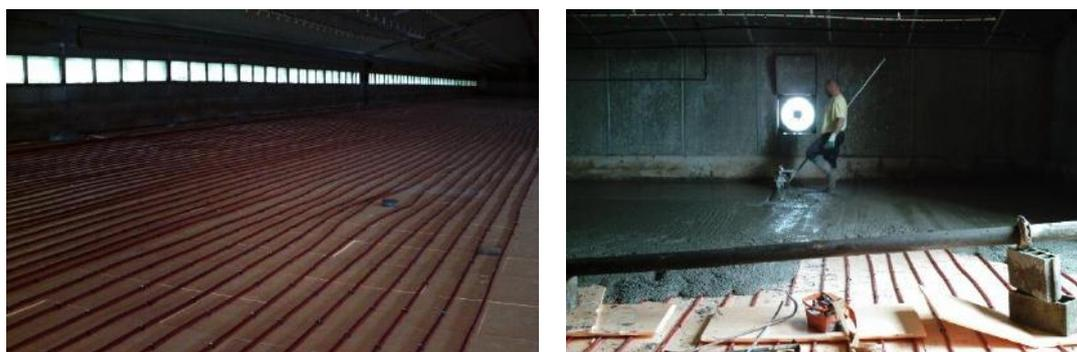
Figure 1 : Exemple d'installation d'échangeur thermique (source ITAVI)
