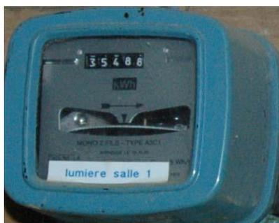
Figure 1 : Exemple de compteur électrique électromécanique
