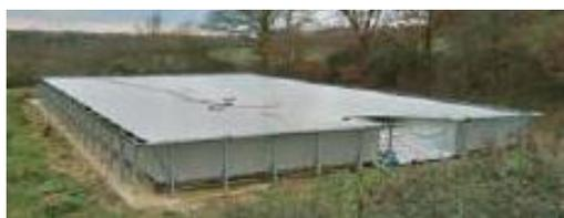
**Photo 2 : Exemple de couverture tendue à plat**
