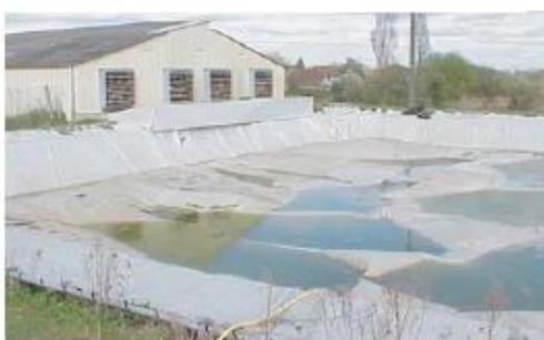
**Photo 3 : Exemple de couverture flottante**
