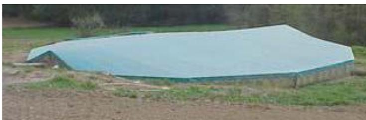
**Photo 5 : Exemple de couverture de type « bâche camion »**
