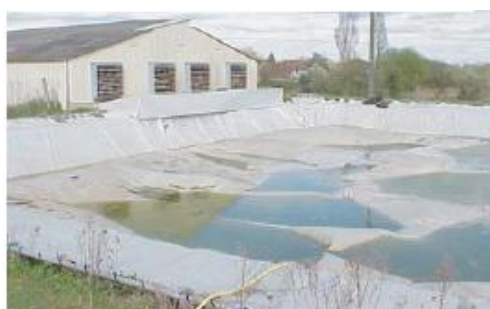
Photo 3 : Exemple de couverture flottante
