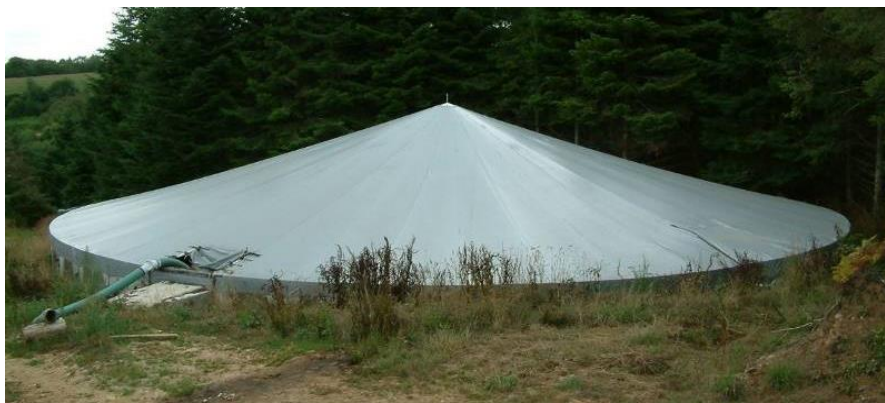
Photo 1 : Exemple de couverture de type chapiteau
