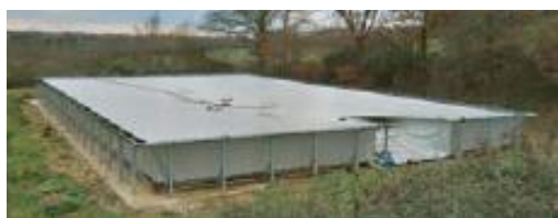
Photo 2 : Exemple de couverture tendue à plat
