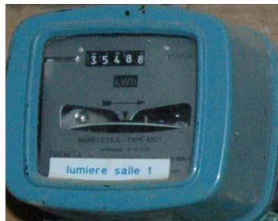
Figure 1 : Exemple de compteur électrique électromécanique
