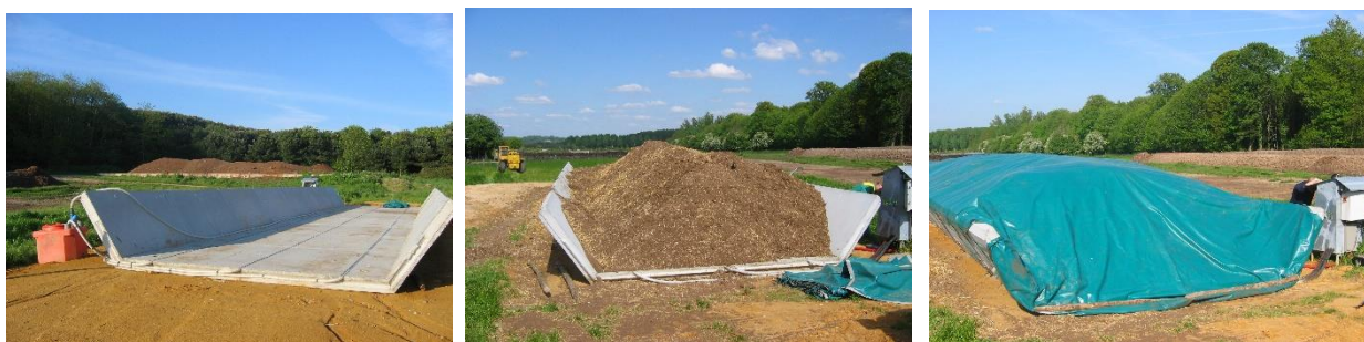
Figure 6 : Exemple de plateforme de compostage sous aération forcée
